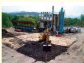
油が含まれた土壌の改良
